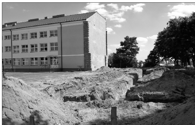
Roboty ziemne - lipiec 2005r.
