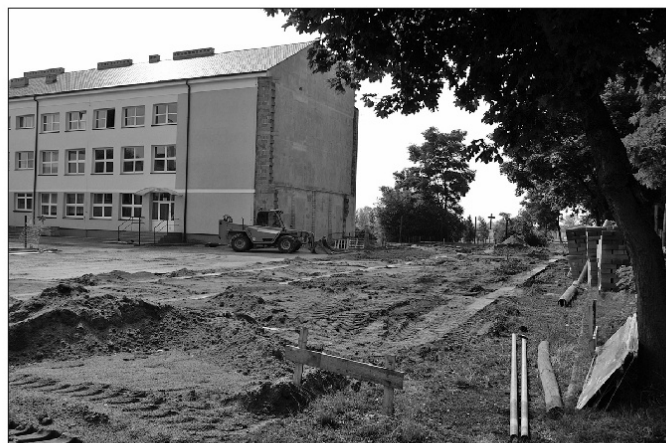
Fundamenty - lipiec 2005r.
