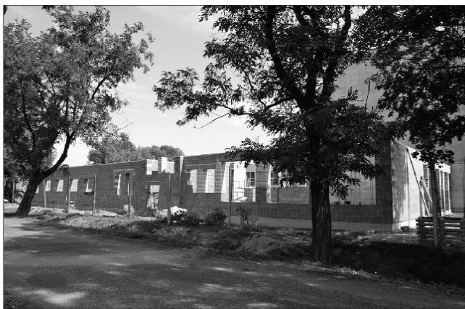
Roboty murowe - III kwartał 2005r.
